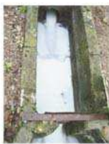
LA GUICHE : rejet de liquide dans les eaux usées
