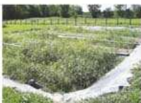
LE FAY : filtre planté de roseaux 1 er étage
