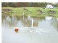
BRÉCOUX - lagune avec aérateurs immergés
