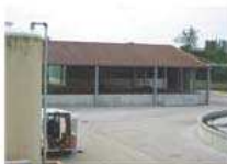
CUSEAUX : aire de stockage des boues
