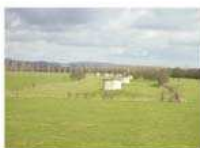
Puits de captage en nappe alluviale
