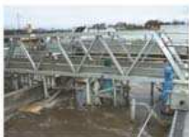
CHALON : boues activées plancher diffuseur
