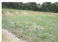
ST ISMIR : filtre à sable enterré et ses avertis d'alésage
