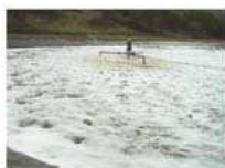
FUISSE - aérateur en fonctionnement
