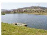
SAINTE-GENGOUX-LE-NATIONAL - 1 er bassin lagunage de capacité de 1100 habitants
