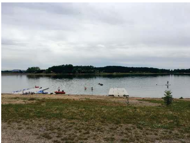
Figure 20: Lac du barrage réservoir de Torcy
