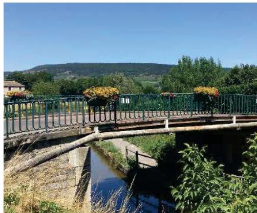
Figure 7 : Pont franchissant le canal à Remigny
