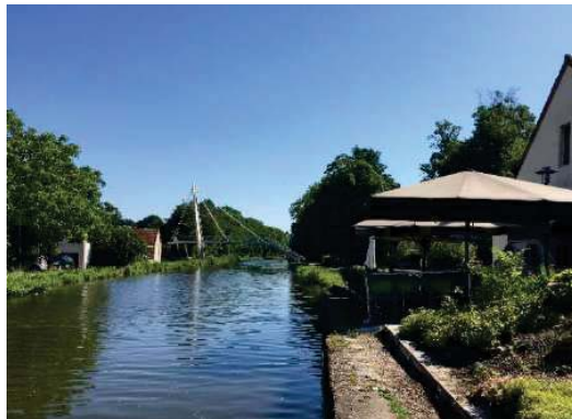
Figure 16 Passerelle à Saint-Léger-sur-Dheune
