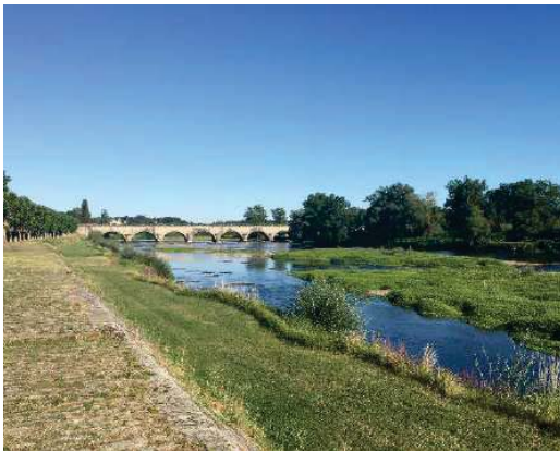
Figure 6: Aperçu du pont-canal de Digoin
