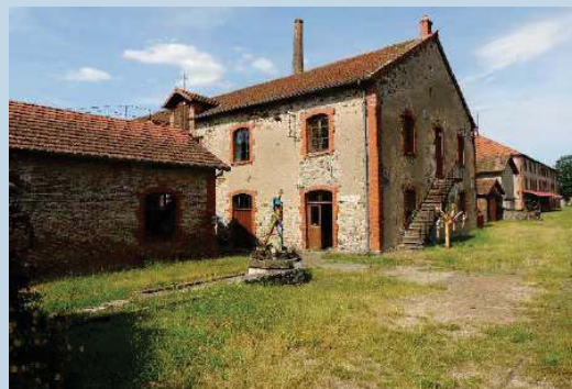
Figure 17: Briqueterie à Ciry-le-Noble
